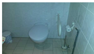
WC-Schüssel im Sanitärraum
