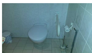
WC-Schüssel im Sanitärraum
