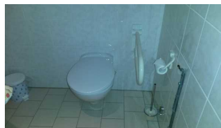
WC-Schüssel im Sanitärraum
